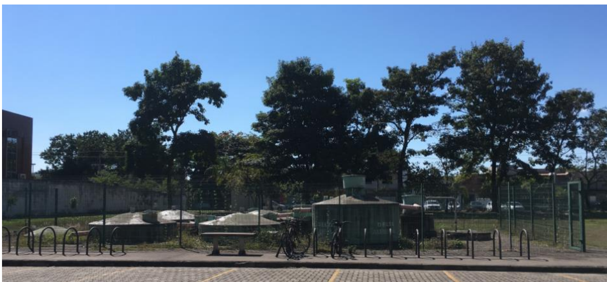
Figura 8. Sistema de tratamento de efluente sanitário na UFF Campus Atterrado
